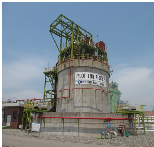
Fig. 1 Pilot LNG storage tank (1,000m 4 )
