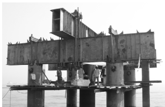
Fig. 1 The test site
