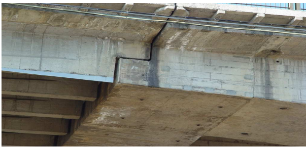
Fig. 1 (d) View of corbel
