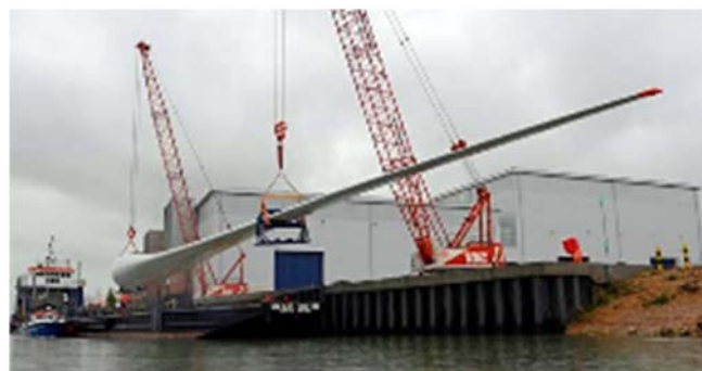
Fig. 6 Blade loadout [16]
