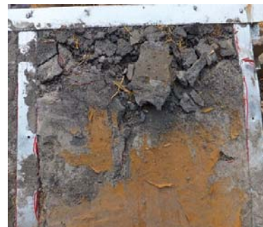
(d) Brittle failure of W-3 FC
